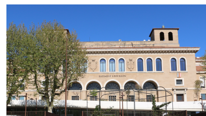
Figura 33: Este é o prédio onde fica o LTD, localizado logo abaixo da pequena torre à esquerda.
