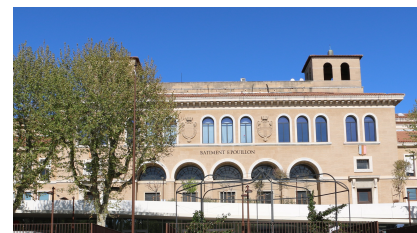
Figura 33: Este é o prédio onde fica o LTD, localizado logo abaixo da pequena torre à esquerda.
